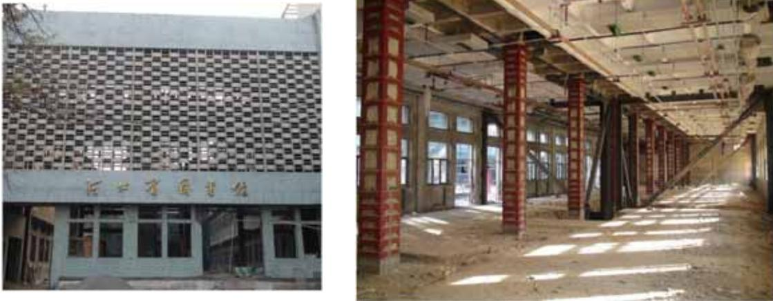
图 1-20 中国河北省图书馆加固改造工程
